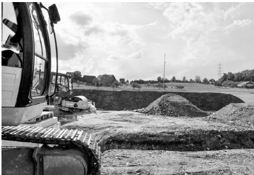
Die Arbeiten an der Umfahrungsstrasse Cham-Steinhausen werden für den Tunnel in Richtung Cham Knonauerstrasse vorbereitet.
