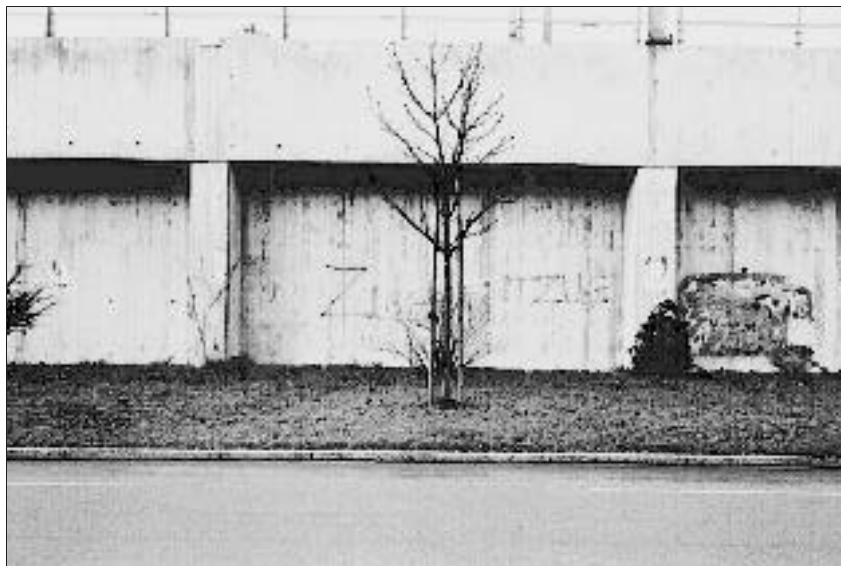
Bahndamm Gotthardstrasse West: Eine riesige Betonfläche, die nur sehr mager begrünt wurde (Efeu, Wildreben). «Nachrüsten» erwünscht!
