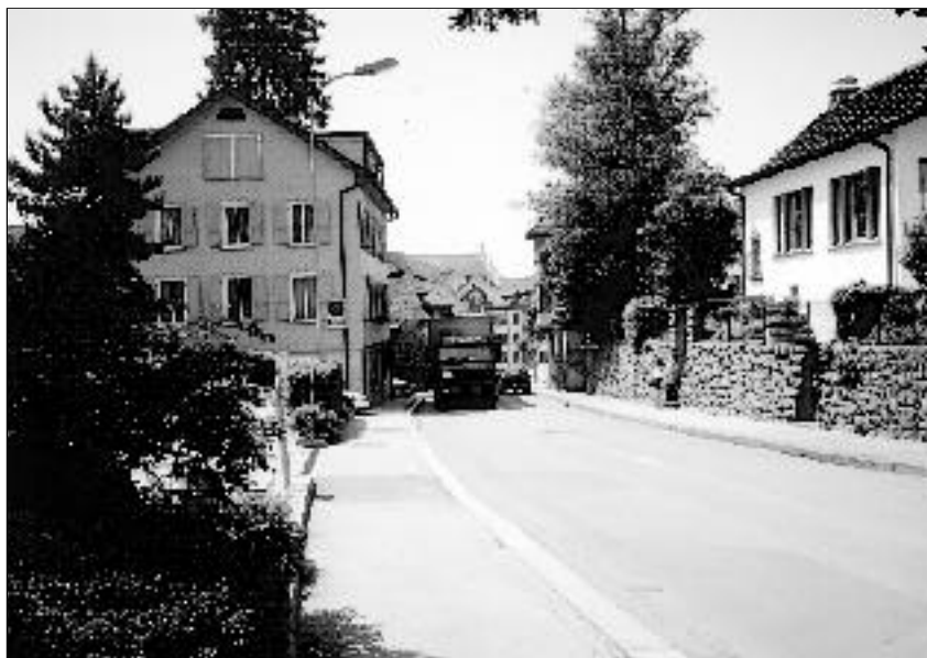
Städtebaulich heikel: der Anschluss Ägeristrasse.
