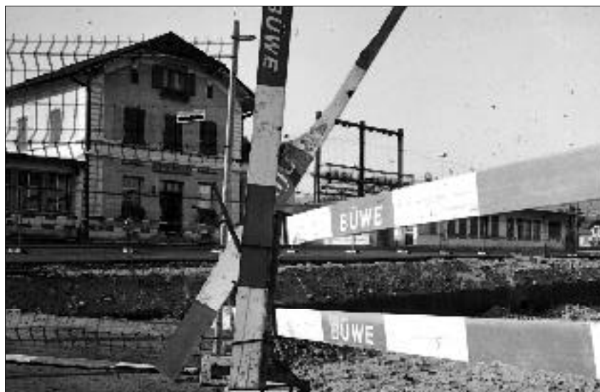
Tiefgaragen statt Personenrampe beim Bahnhof Baar.
