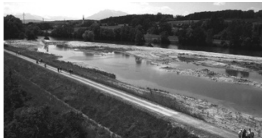
Dank Einsprachen wurde der Kanton gezwungen, bei der Reussdammsanierung neben dem reinen Hochwasserschutz auch die ökologischen Funktionen des Gewässers zu verbessern. Markantestes Resultat ist die Reussaufweitung zwischen Zollweid und Mühlau.
