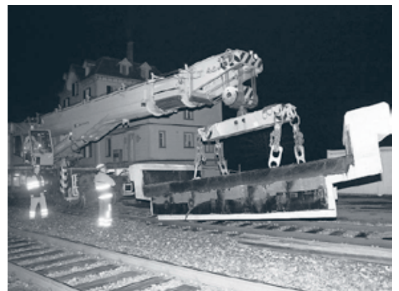
Die 50 Tonnen wiegende Brücke hängt am Haken des Schienenkrans, nun kann der Transport beginnen.
