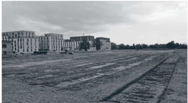
Die Landsanierungen sind in vollem Gange. Zurzeit wird der bestehende Oberboden abgetragen.
