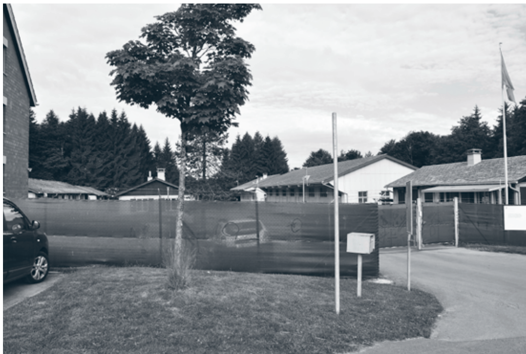
Abgeschiedener Gubel: Die umgebaute Militärunterkunft in Menzingen wird als Bundeszentrum (BZ) für Asylsuchende genutzt.
