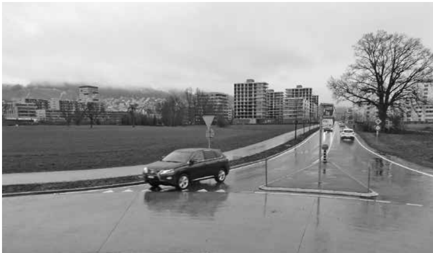
Dieser Kreiselparkplatz wird die Nordzufahrt zur Überbauung Unterfeld bilden.
