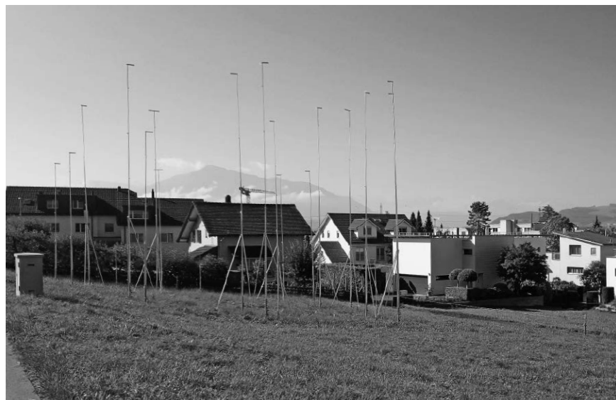
Bauprofile, ein alltägliches Bild in der Schweiz.
