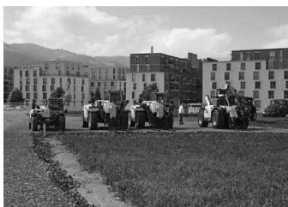
Für die Planierung und Vorbereitung des Bodens wird schweres Geschütz aufgefahren.
