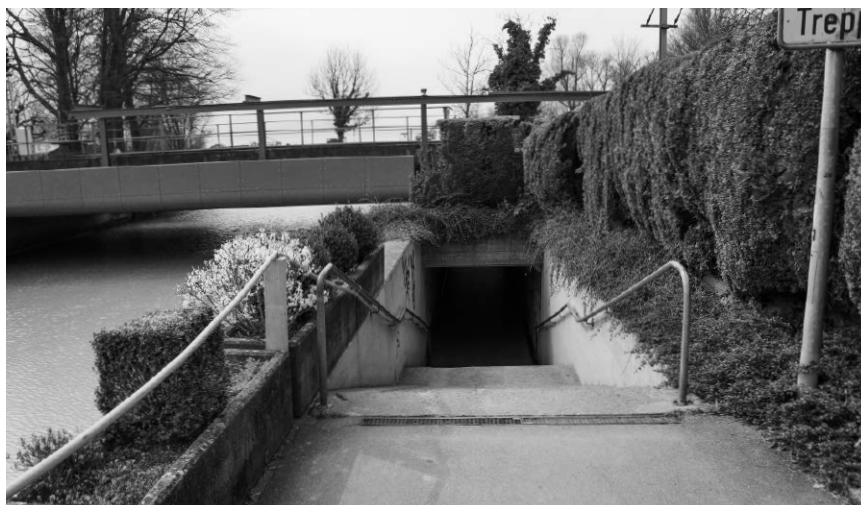
Schwachstelle Brüggli: Die Hauptveloroute an der Lorze wird beim Brüggli jäh von einer steilen, mit Anhänger kaum passierbaren Unterführung unterbrochen. Die Unterführung sollte velo- und rollstuhlgängig gestaltet werden.
