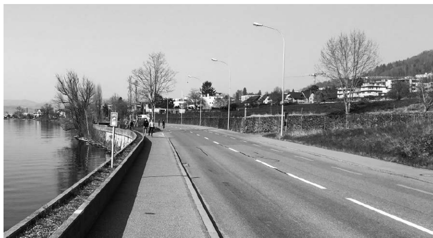
Schwachstelle Einfahrt Oberwil: Auf der Fahrt von Walchwil nach Oberwil muss man kurz vor dem Ortseingang von Oberwil die Hauptstrasse queren. Im weiteren Verlauf sind noch drei weitere Querungen vonnöten.
