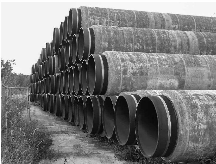
Mit Nord Stream 2 werden über 1230 Kilometer Gasrohre in der Ostsee verlegt.
