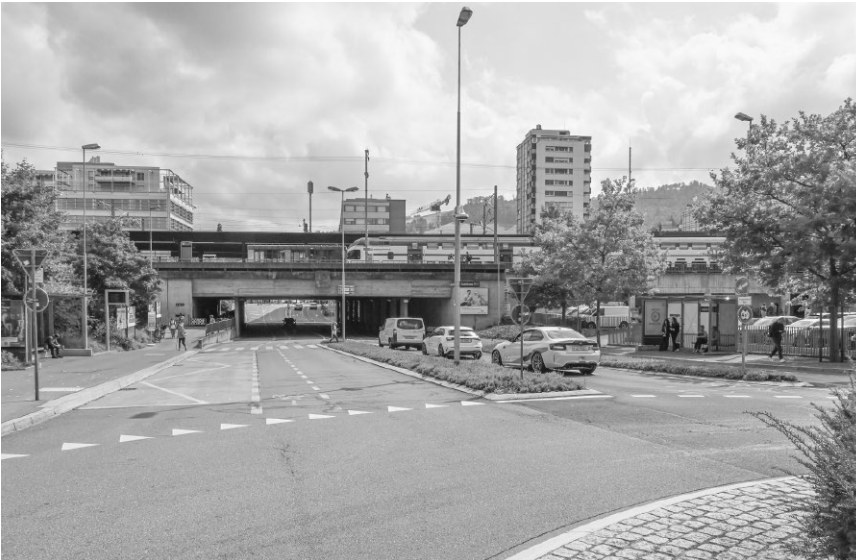
Hier sollen dereinst 4 Strassenspuren nebeneinander zu liegen kommen.
