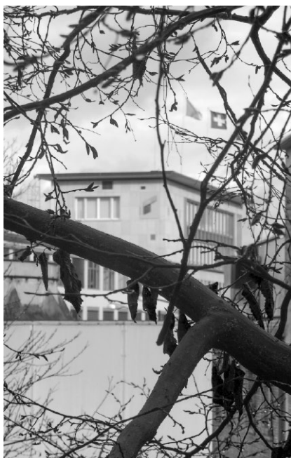
Rheinmetall, an der Birchstrasse in Zürich-Oerlikon, Foto Heinrich Frei
