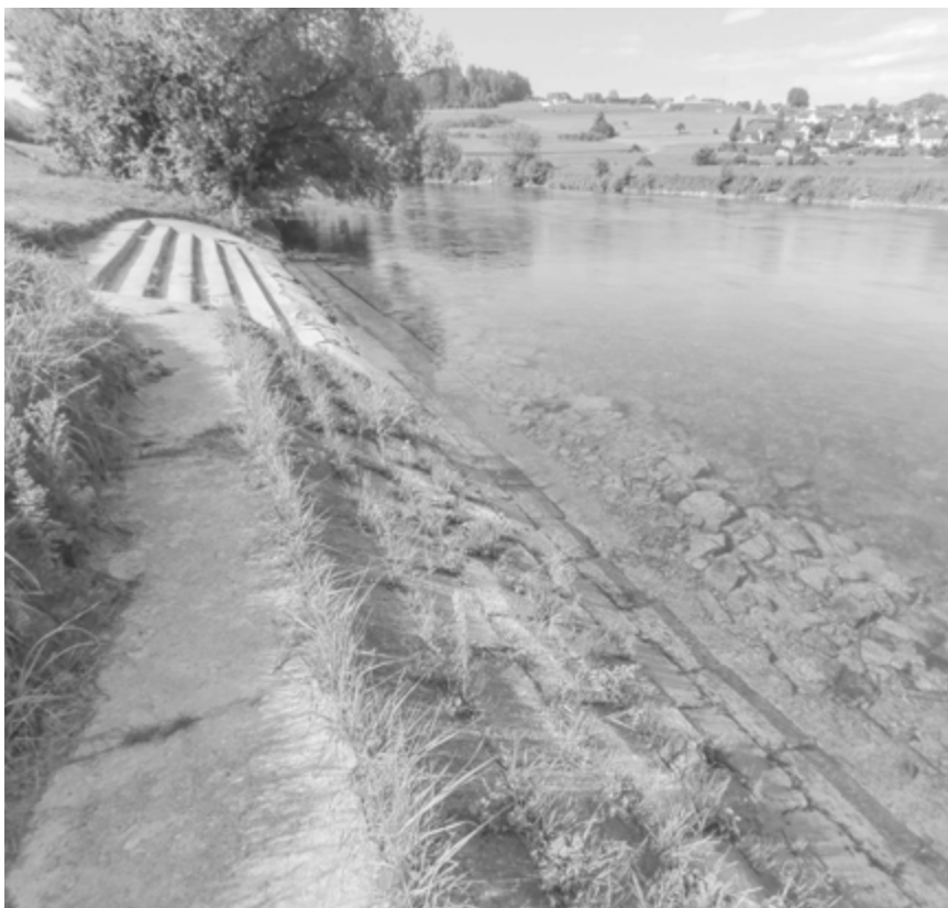
Beton anstatt Biodiversität – so sehen die Reussverbauungen heute aus.
