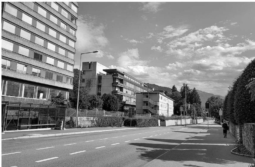
Das alte Kantonsspital dient als kantonale Asylunterkunft. Die dreistöckige Container-Siedlung wurde als temporäre Erweiterung gebaut.
